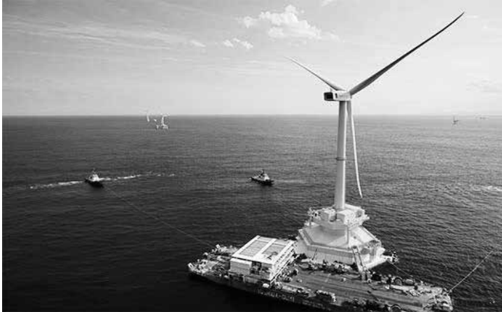
【図5】日本の浮体式洋上風力発電「ふくしま浜風」
