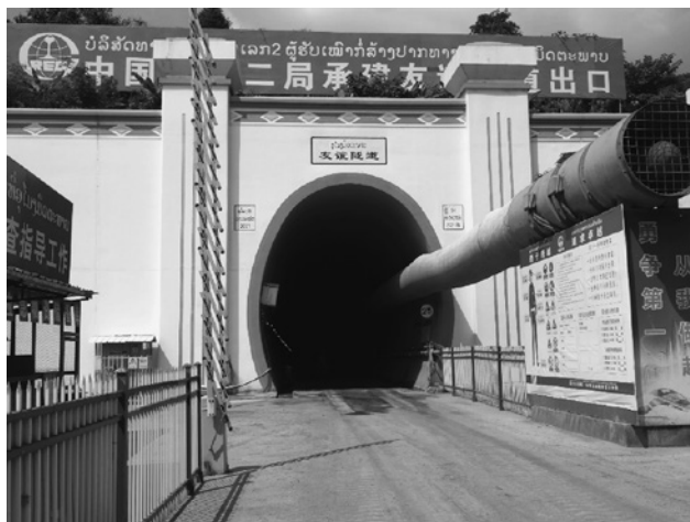
図表5 ボーテン工区におけるトンネル（導坑）掘削
