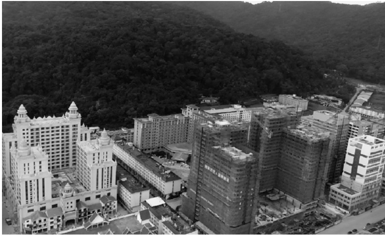
図表9 ボーテンSEZで建設が進むビルディング群
