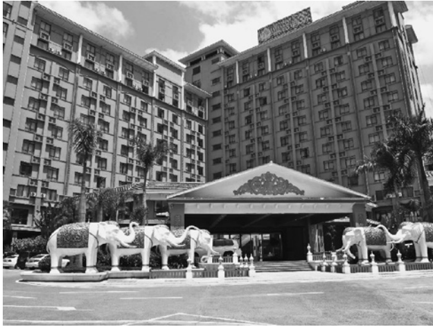
図表8 ボーテンSEZにて稼働中のホテル
