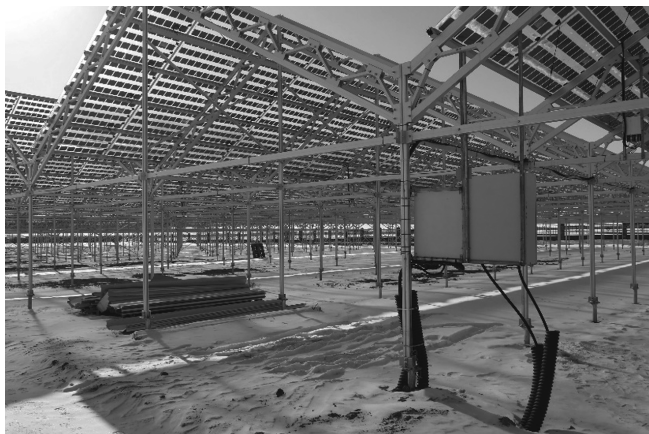
図3 下部から上部のパネルを見る
