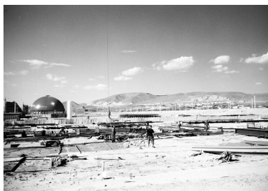
写真-25 建設中の石炭液化プラント
